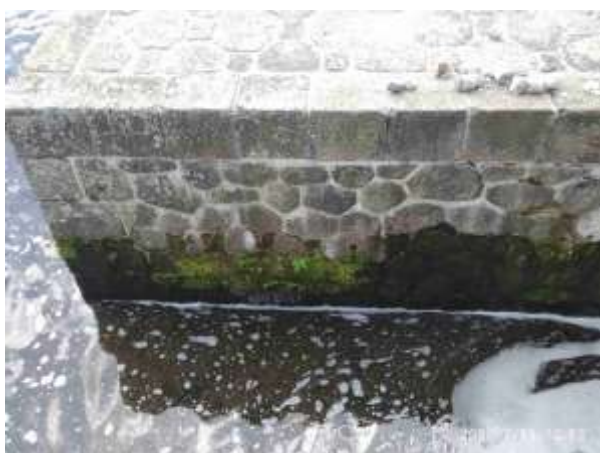
Dělicí pilíř ze strany ŠP, průsaky
