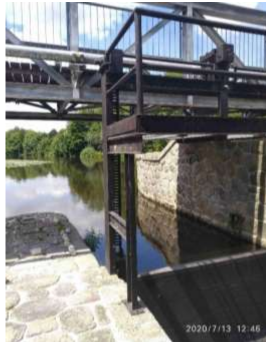
Spojení lávky ŠP s dělícím pilířem
